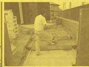
タイル工事を 行いました。
