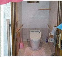
手すりを取りつけ バリアフリーに。
