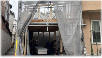
東大阪の物件 棟上しました
