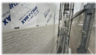
岩倉の物件 外壁工事
