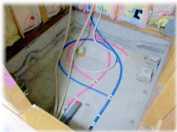
北区の物件 風呂工事
