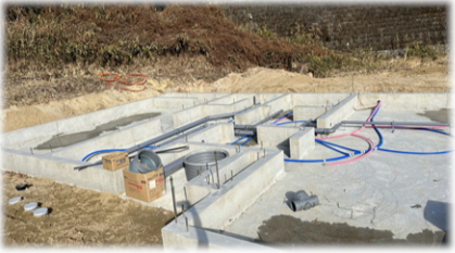
生駒の物件 水道工事
