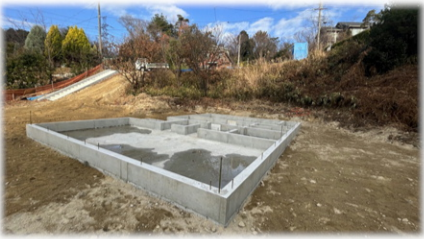
生駒の物件 基礎工事
