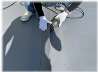
※鳴滝の防水工事
