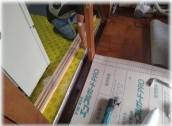
※北区の修繕工事
