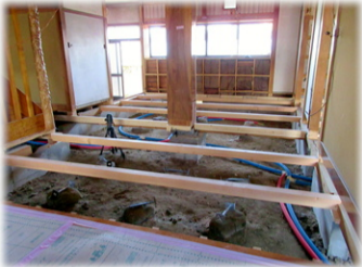
※伊那の解体です
