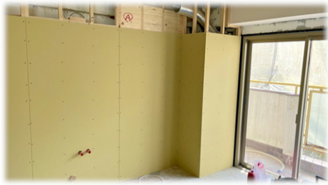
※鳴滝の物件の石膏ボード貼りです
