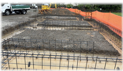
上賀茂の物件 基礎工事完了
